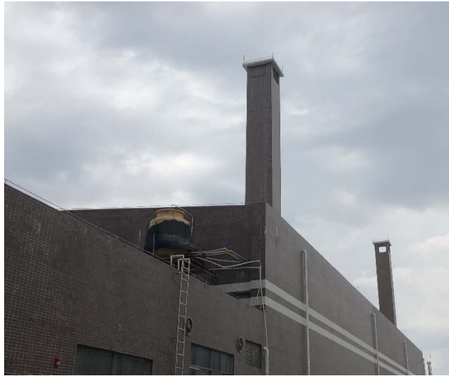
图 5-10 辐照车间屋顶的排风口
