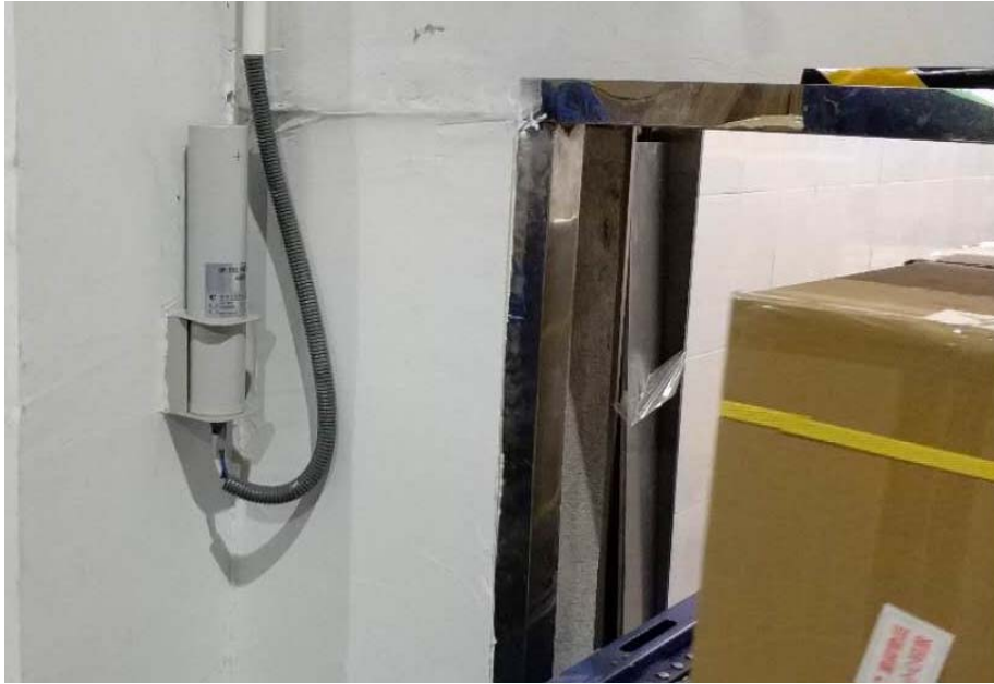
图 5-7 传输窗口的辐射在线监测设施探测器
