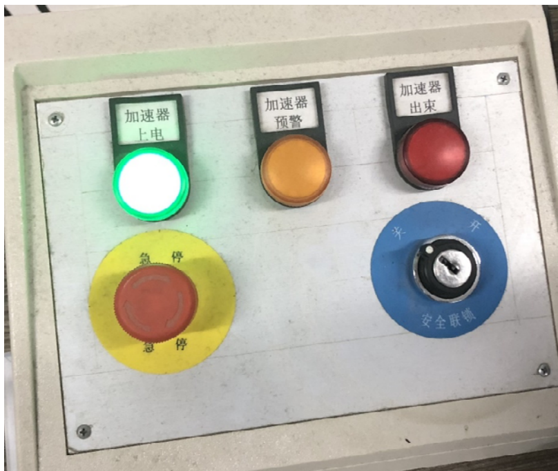
图 5-1 主控室控制台上的工作状态指示灯、急停按钮和开机钥匙
